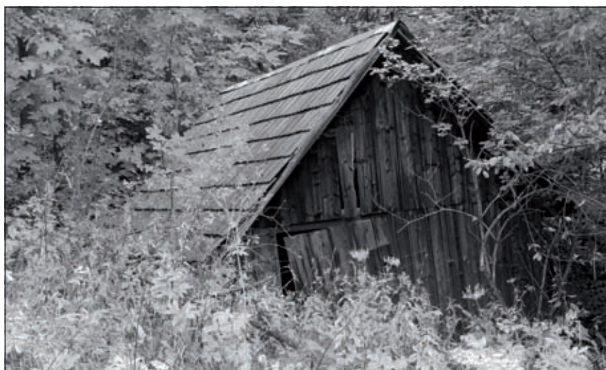
Na okraji nejednoho opuštěného ovocného sadu se po celém Horním Vsacku krčí nenápadné stavbičky, jejichž původní využití si pamatuje už jen málokdo – sušírny ovoce - zde jedna halenkovská. Foto© R. Páleníková
