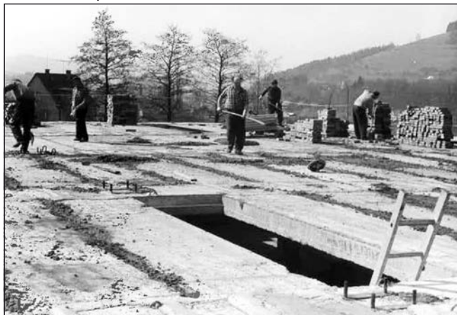
Stavba nákupního střediska
