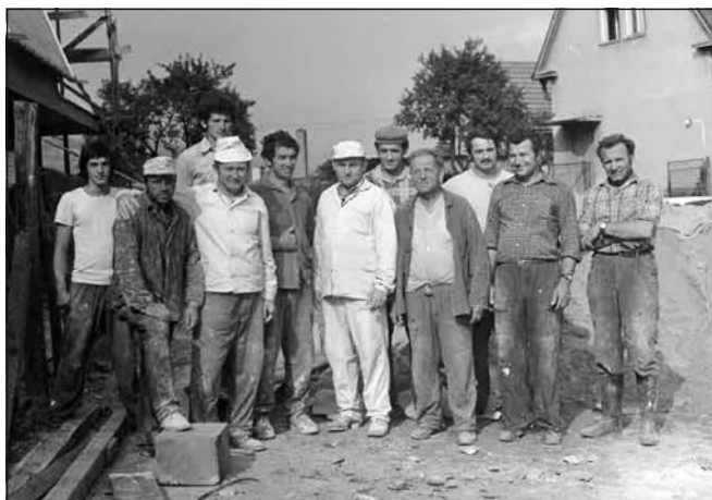
Stavba nákupního střediska
