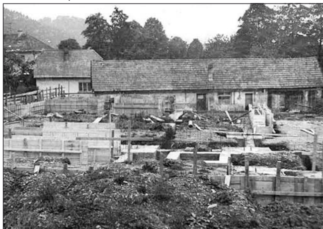
Stavba nákupního střediska
