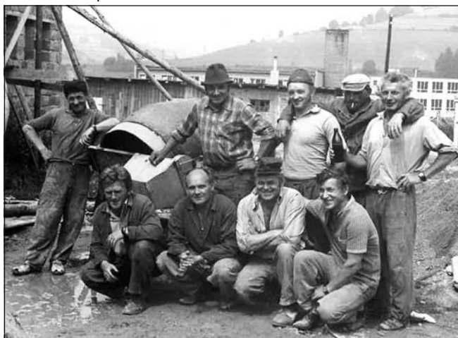
Stavba nákupního střediska
