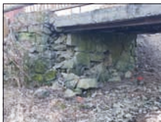
Most u Pončíků před rekonstrukcí
