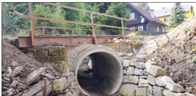
Hotová sanace mostu u Hastíků
