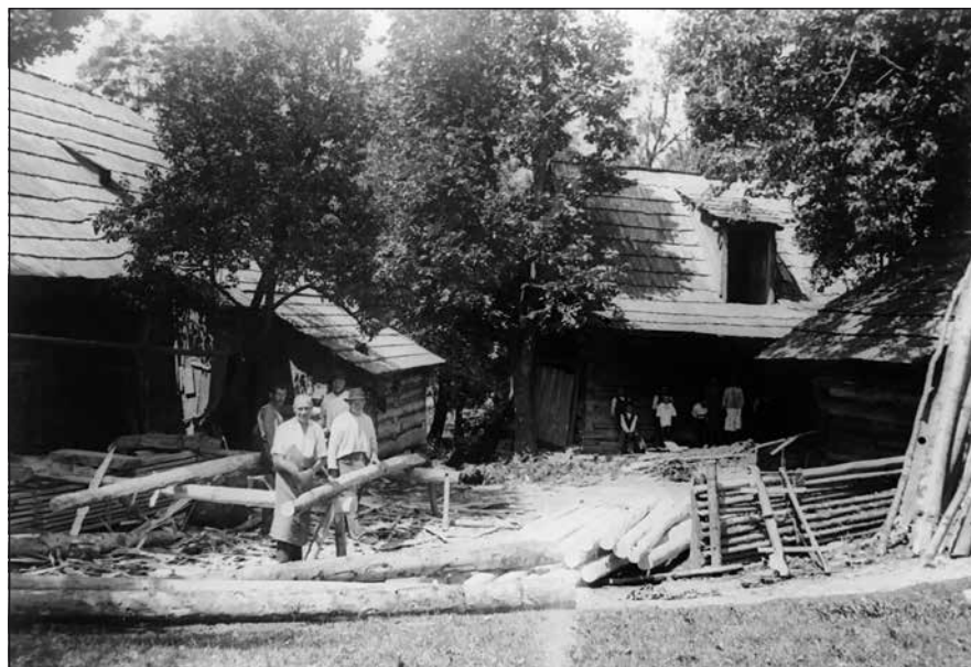
Tesaři krovu u Blahů Pod Černým kolem roku 1930
