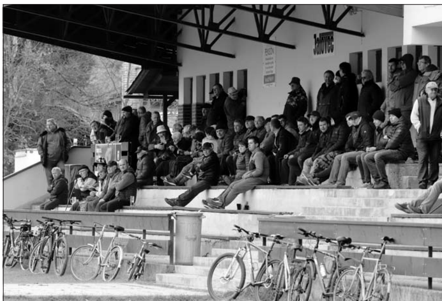
V letošním roce se možná dočkají opravy obě části tribuny, které bývají při utkáních halenkovského áčka pravidelně velmi slušně zaplněny.
