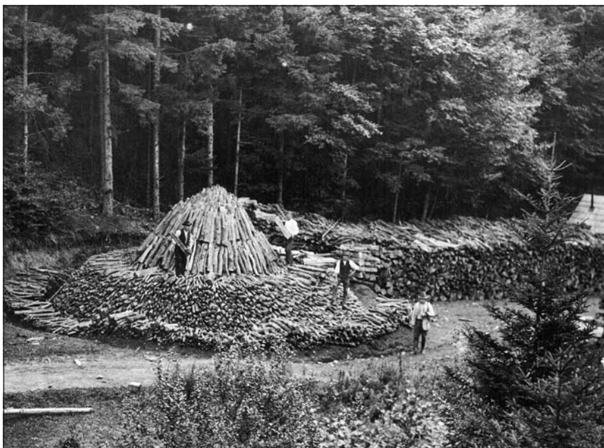
Thonetův milíř v Dinotici , 1927, foto K. Puzskailer; Fotoarchiv Muzea regionu Valašsko, p. o., inv. č. VS22253. Do milíře této velikosti uhlíři naskládali 250–280 m 3 dřeva, aby z něj po zhruba dvou týdnech pálení vybrali kolem 50 košů dřevěného uhlí (zhruba 1 400 kg). Taková zásoba uhlí z tvrdého dřeva vydržela jedné vysoké peci na dva dny provozu. Dřevěné uhlí z měkkého dřeva odebírali kováři či hamerníci.
