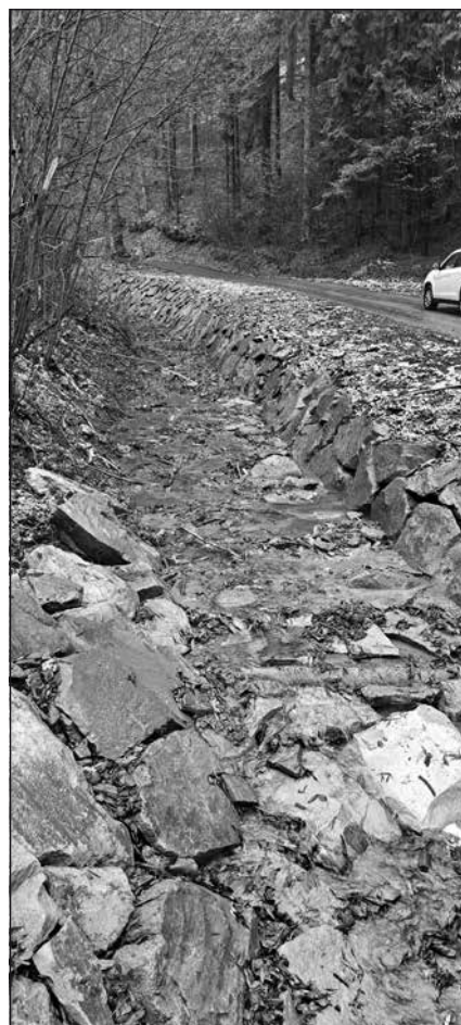
Lušová břeh po opravě
