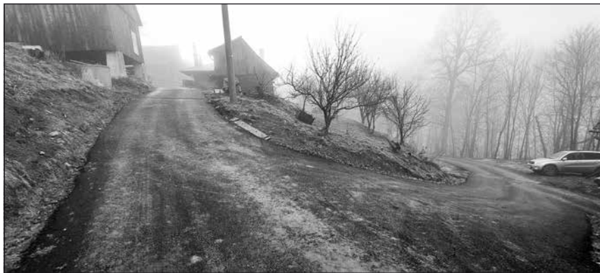
Křižovatka u Ščulků po opravě
