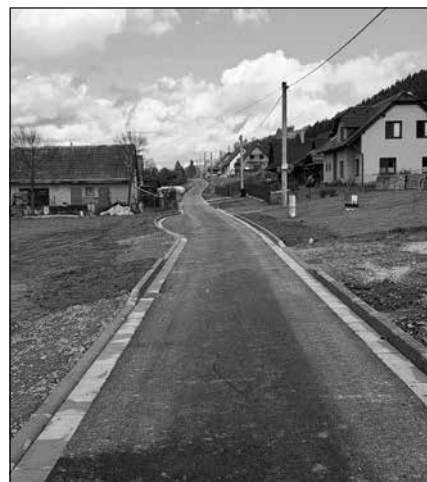
Cesta pod Provazníčkem po opravě
