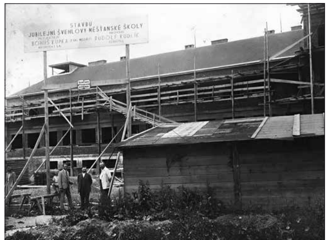
Staveniště Jubilejní Švehlovu měšťanské školy v Novém Hrozenkově (Archiv Základní školy Nový Hrozenkov)
