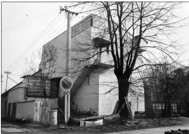
Přestavba rodného domku na Vrbenské ulici na rodinný dům a architektonický ateliér (Fotoarchiv MRV)
